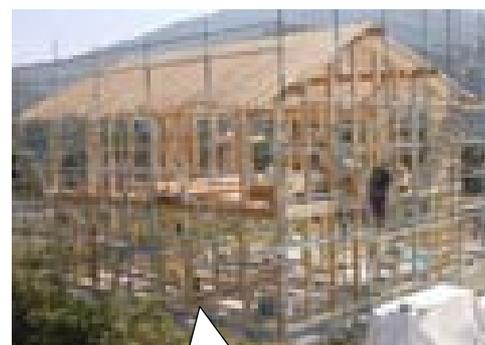
シンプルな架構で合理的な構造を採用することで、柱本数が少なくなる、材せいが小さくなる、施工の合理化がはかれるなどコスト低減が可能です
