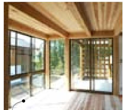
スギを柱、床、天井、2F床組材に用いた例
