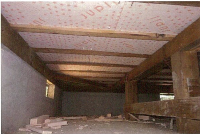
施工後 ジュピーは釘斜め打ちで施工
