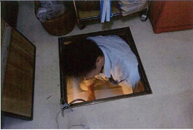
勝手口近くの床下収納から施工)
