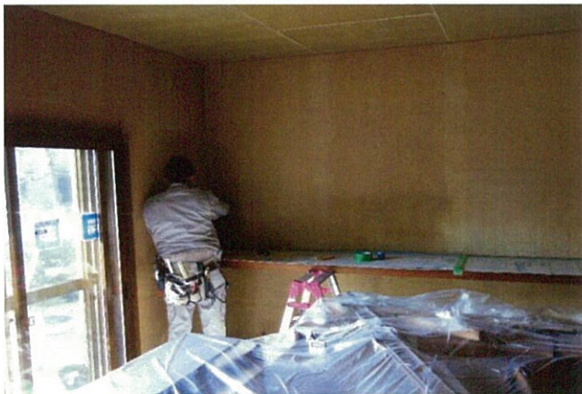
施工前の様子
