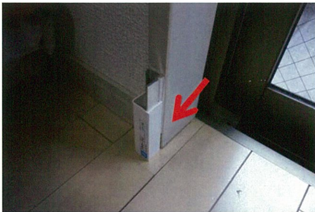
フレーム材を施工
