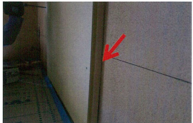
施工された断熱ボード
