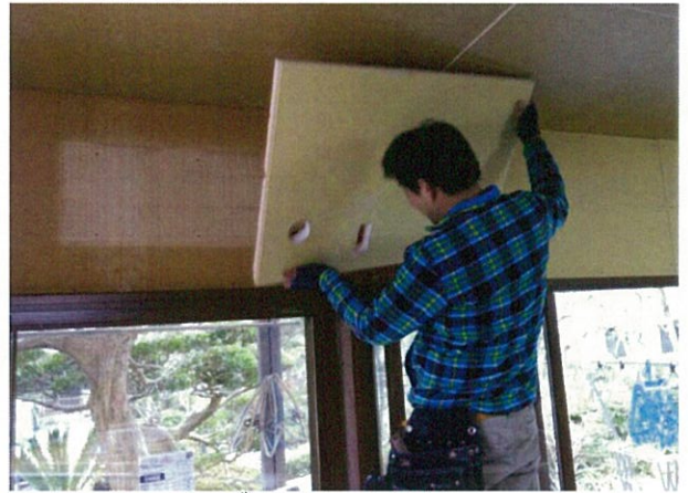
エアンスリーブ・コンセント処理
