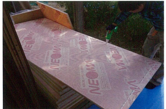
搬入された断熱ボード
