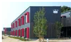
CLT工法による木造ホテル
