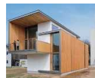
CLT工法による実験棟
