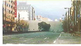
倒壊し避難路を塞いだ建築物
