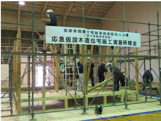
1/16 実技実施風景(界壁施工:断熱材・ボード貼り) ↓
