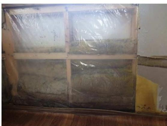
写真11：壁内部の断熱材が吸水し、脱落している。
