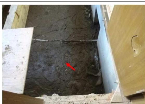
写真2：床下への浸水により、汚泥が流入し堆積している。
