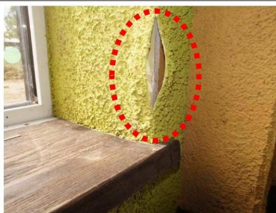
写真10：内装仕上げ及び下地材が水分を含み、膨張・剥離している。
