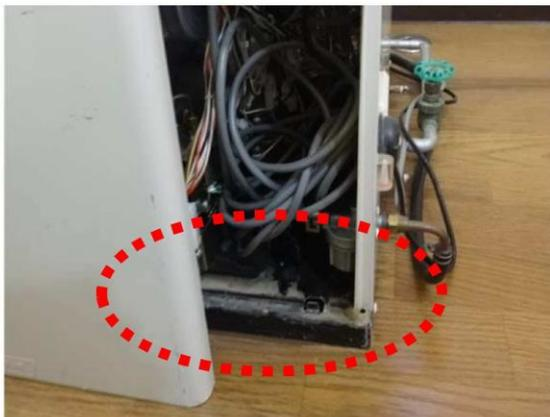
写真7: 床に設置した設備が浸水し、内部に汚泥が侵入した形跡がみられる。
