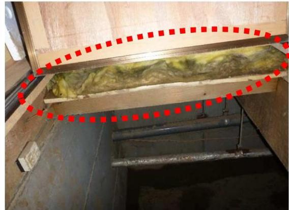
写真6: 床上への浸水により、床の断熱材が水と汚泥により汚損している。
