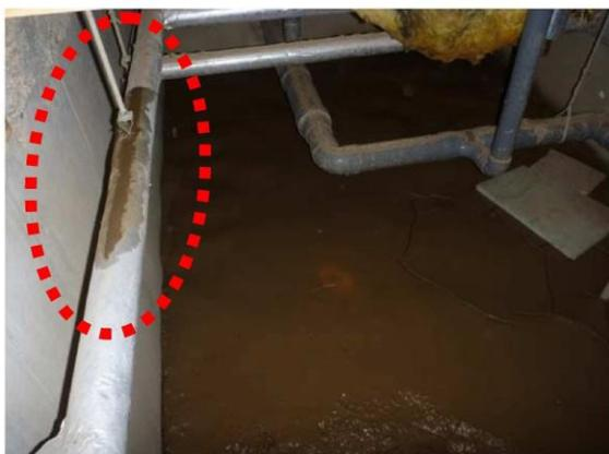
写真3：床下への浸水により、設備配管の保温筒が水分を含んでいる。
