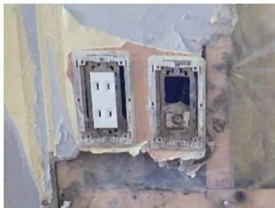
写真12：壁に設置されたコンセントボックス内に汚泥が残っている。
