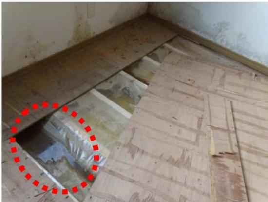
写真5: 床上への浸水により、床下地と防湿フィルムの間に水がたまっている。
