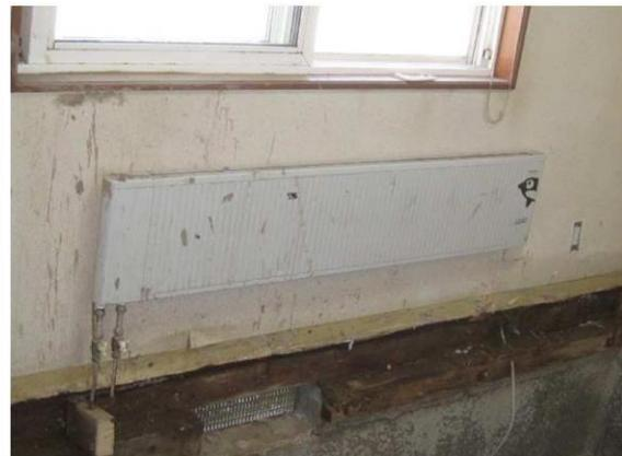
写真8: 壁に設置されたパネルラジエーターの温水管に浸水の形跡がある。
